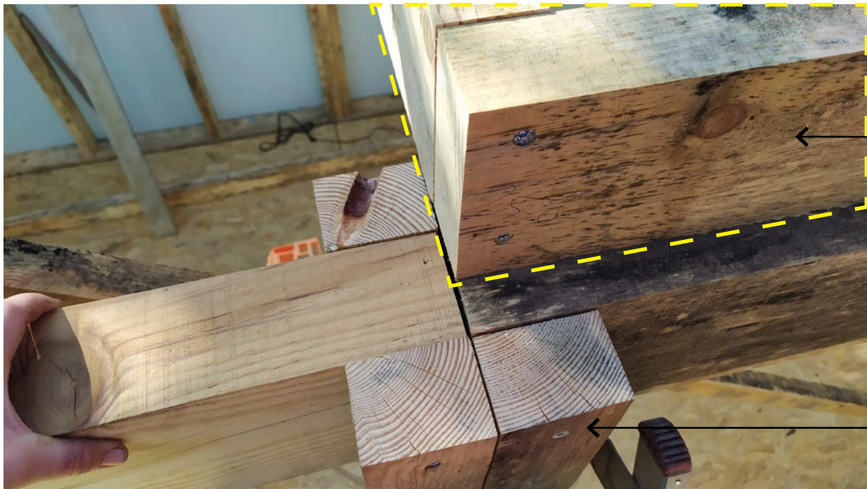
Détail encastrement poutre sur poteau central
