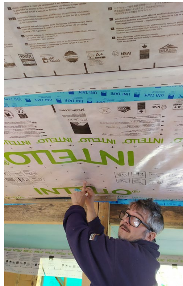
Pare-vapeur scotché aux bords et aux jonctions
