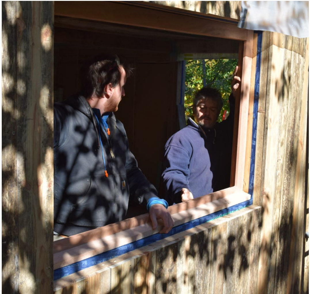
Pose menuiserie et traitement de l'étanchéité à l'air et à l'eau
