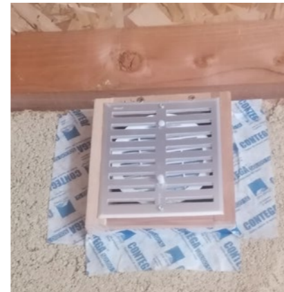
« Grille de ventilation à ouverture manuelle »
