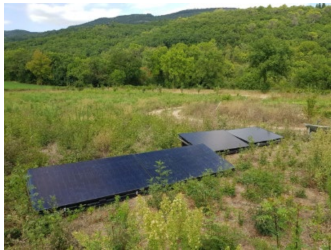
Panneaux solaires PV installés sur les bacs lestés, orientés sud, avec inclinaisons d'environ 15°.
