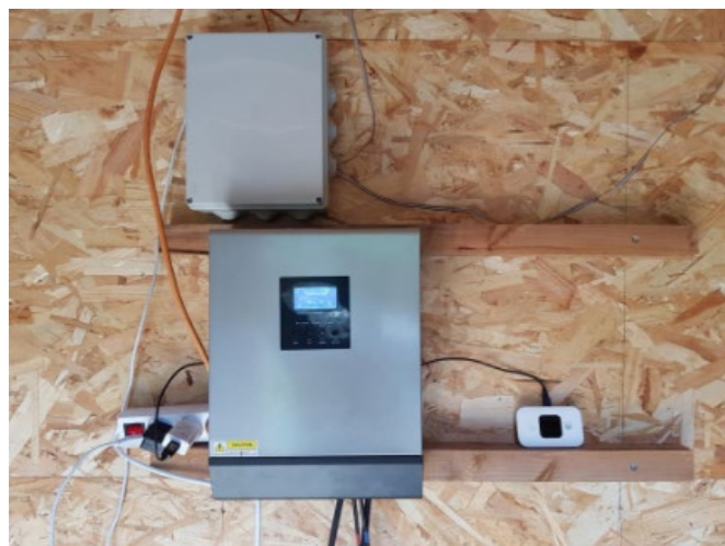
Onduleurs : 4 fils noirs du bas : 2 pour l'arrivée PV, 2 pour l'arrivée batterie. Fil blanc vers le bas permet de se brancher au réseau (ou groupe électrogène) si possibilité. Le câble blanc vers le côté : sortie de l'onduleur pour alimenter le climatiseur.
