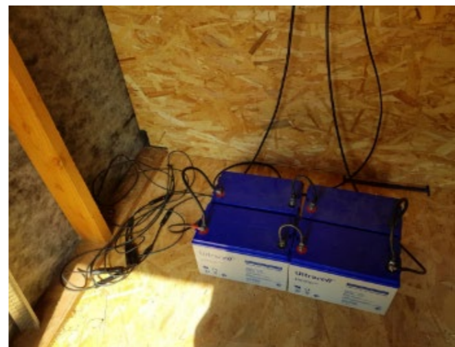
Pack de 4 batteries. (2 séries de 2). Sur la gauche, arrivée des câbles solaires.
