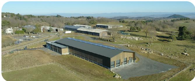
Le nouveau bâtiment d'accueil du site de Theix, véritable point névralgique du Centre, incarne notre engagement en faveur de la transition écologique : construit en ossature bois, isolé en paille, doté d'équipements d'efficacité énergétique et en partie réalisé avec des matériaux issus de la déconstruction, il conjugue innovation architecturale et sobriété environnementale.
