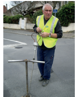
Réalisation d'une écoute directe mécanique (source : Irstea)
