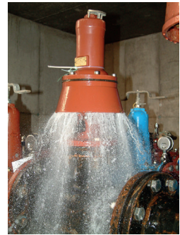
Soupape de décharge en fonctionnement (source : OIEau)
