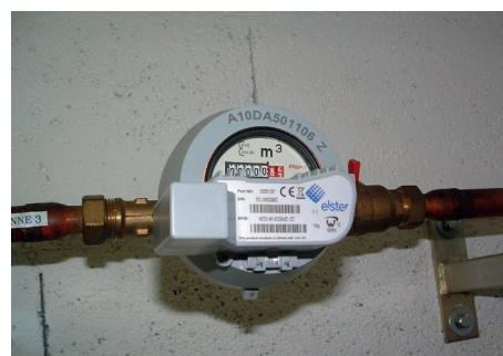
Compteur d'eau d'un abonné (source : OIEau)
