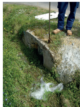
Réalisation d'une purge (source : Irstea)
