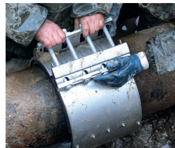
Installation d'un manchon de réparation (source : Norham)
