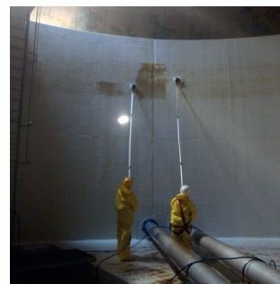
Lavage d'un réservoir (source : Herli)
