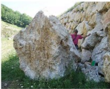
Bloc retenu par le remblai (flan est du Néron) (Crédit : Sage Ingénierie)
