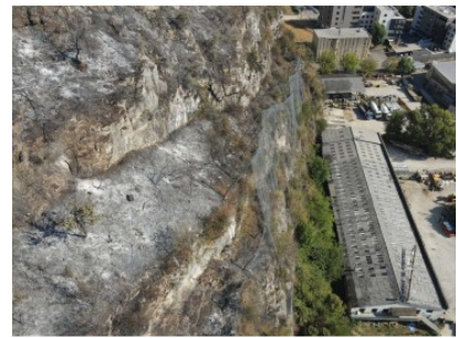
Filets métalliques en amont de zones urbanisées (Les Balmes) (Crédit : SDIS 38)
