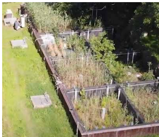
▼ Plateformes expérimentales permettent de faire évoluer les procédés de traitement et de valorisation des eaux usées urbaines vers de nouvelles applications pour favoriser la biodiversité et contribuer à l'économie circulaire. Les enjeux : valoriser la matière, l'énergie et réutiliser les effluents traités. Unité de recherche : « REduire Réutiliser Valoriser Les Ressources Des Eaux Résiduaires » (REVERSAAL)
