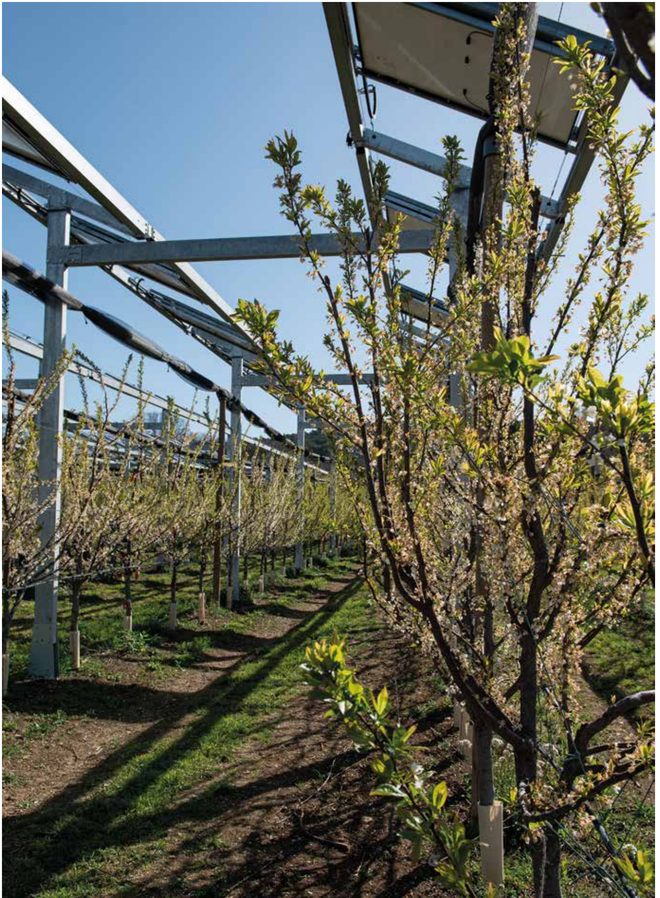
^ Ombrière photovoltaïque sur une parcelle de pruniers à Apt (84). L'impact de la présence des panneaux photovoltaïques sur la production arboricole est mesuré et quantifié. ©INRAE - B. Nicolas
