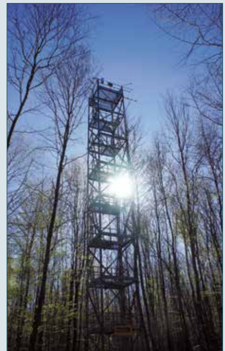
Sur le site ICOS de Hesse, cette tour à flux de 35 mètres mesure en continu les échanges gazeux (CO 2 , gaz à effet de serre...) entre la forêt et l'atmosphère.
