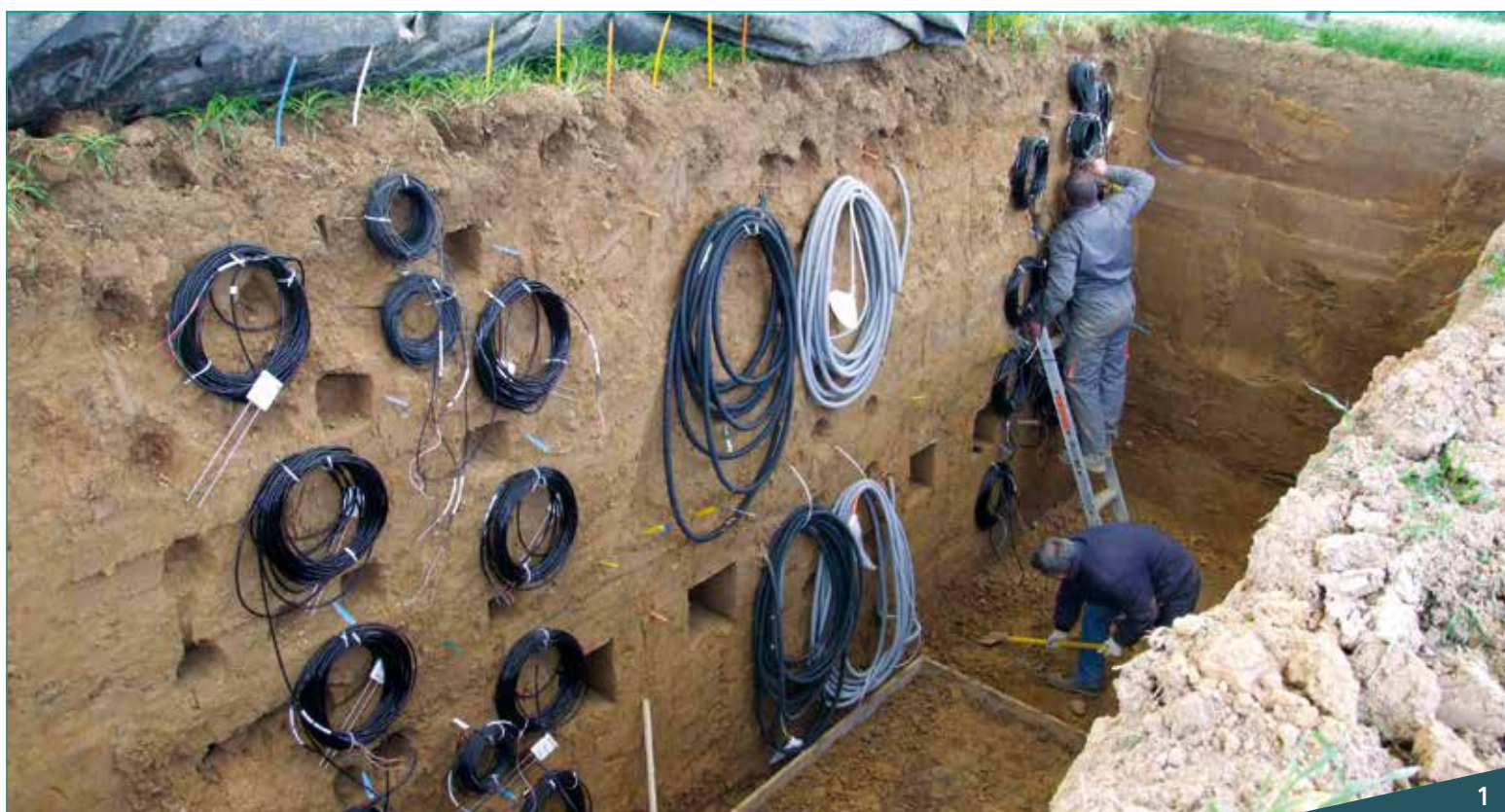
1 Pose de 300 capteurs dans le sol du SOERE ACBB. © N. Brunet, INRAE
